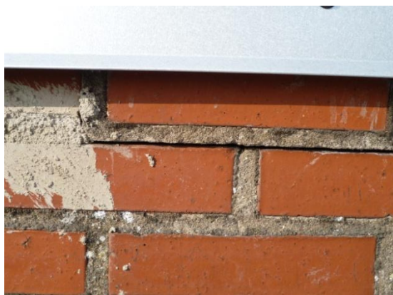
Sprickbildning i skorsten kv. Foten
