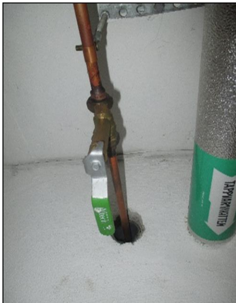
Ärgade tappvattenventiler bytes ut under 2016
