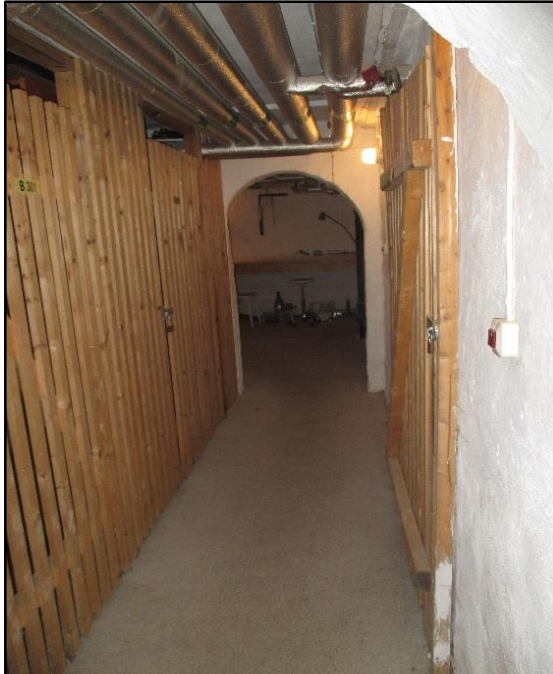
Källare med putsade väggar och förråd
